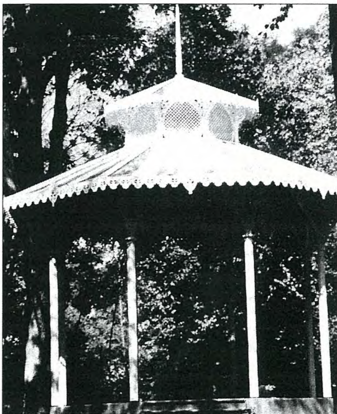
Rechtzeitig zum Tag des Offenen Denkmals ist die Restaurierung des historischen Pavillons im Rumpenheimer Schlosspark abgeschlossen. Foto: beba
