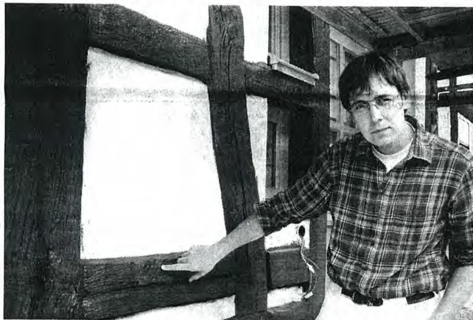
Malermeister und Restaurator Jürgen Jobmann hat sich der neuen Farbgebung der Fassade angenommen. Fotos: Schimpfermann
